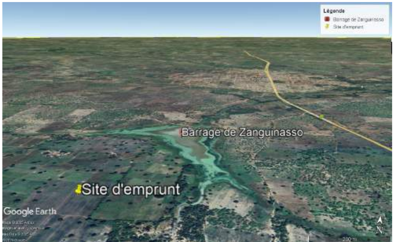
Figure 9 : Localisation de la zone d'emprunt
