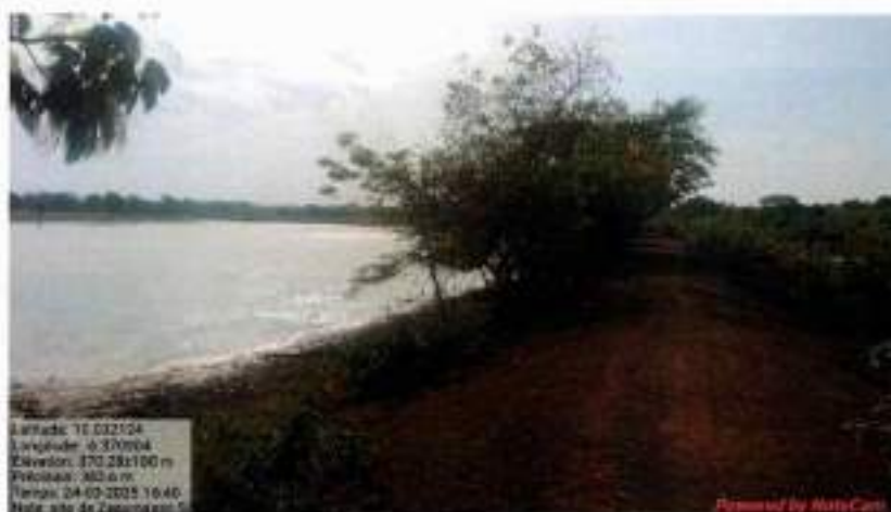
Figure 1 : Une vue de la digue à réhabiliter (ANDE, 24 mars 2025)
