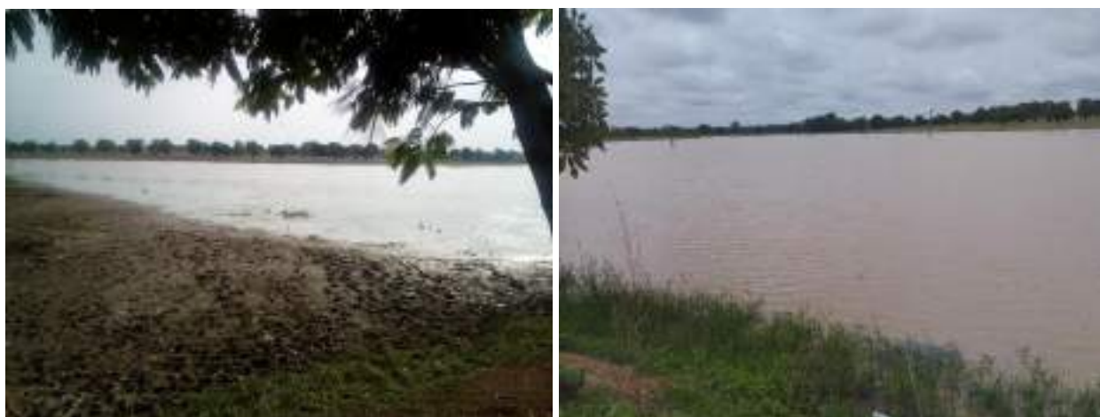
Figure 19 : Vue du barrage de Zaguinasso
