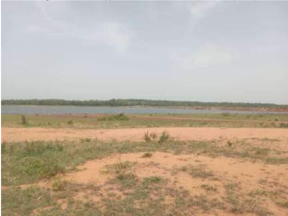
Figure 14 : Vue du barrage de Gbémou
