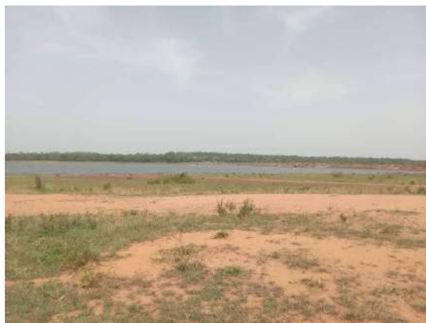
Figure 15 : Vue du barrage de Gbémou
